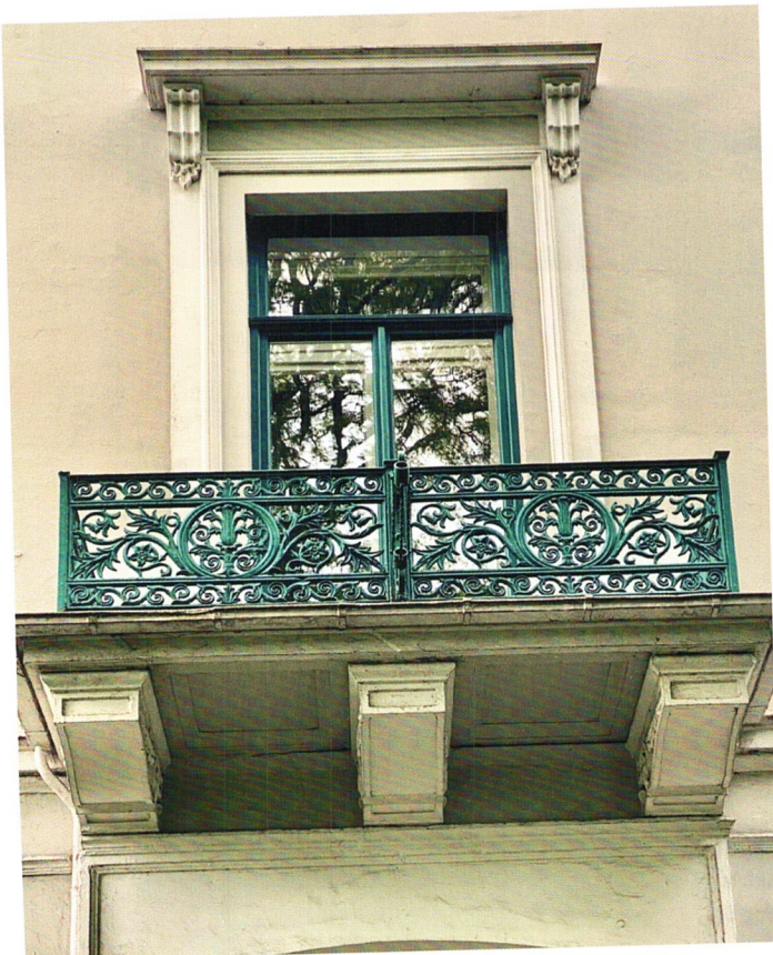
Contrescarpe Nr. 33 - erbaut von Lüder Rutenberg mit einem gußeisernen Balkongitter von der Eisengießerei Uthhoff in Bremen Vegesack.
